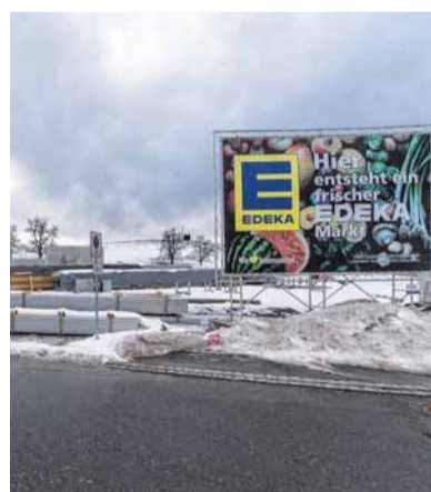
Auf der Edeka-Baustelle in Rothkreuz herrscht vorerst weiter Stillstand. ARCHIVFOTO: CHRISTIAN FLEMMING
