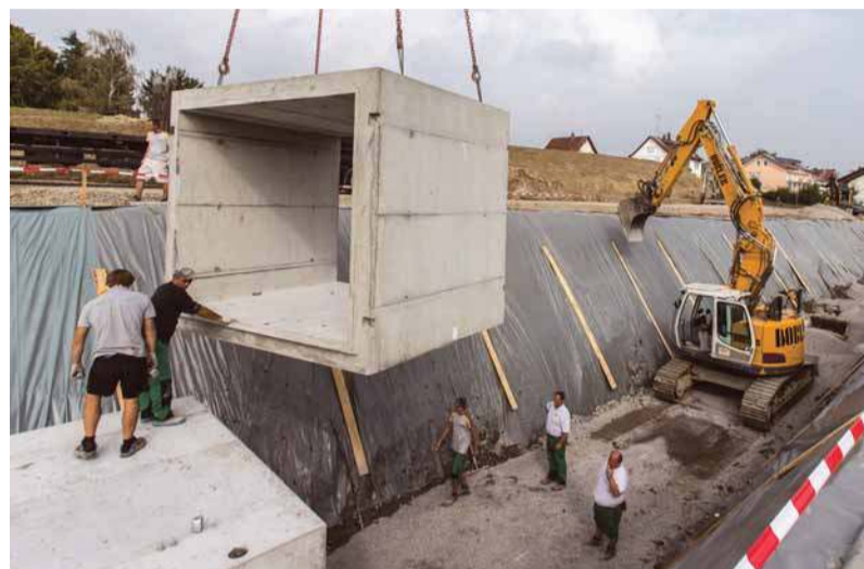
2014 stand in Wasserburg im Zeichen großer Projekte: Beim Baugebiet Wasserburg Nord gehen die Arbeiten schnell voran. Im Bild werden Teile fürs Regenrückhaltebecken geliefert. ARCHIVFOTOS (2): CHRISTIAN FLEMMING
